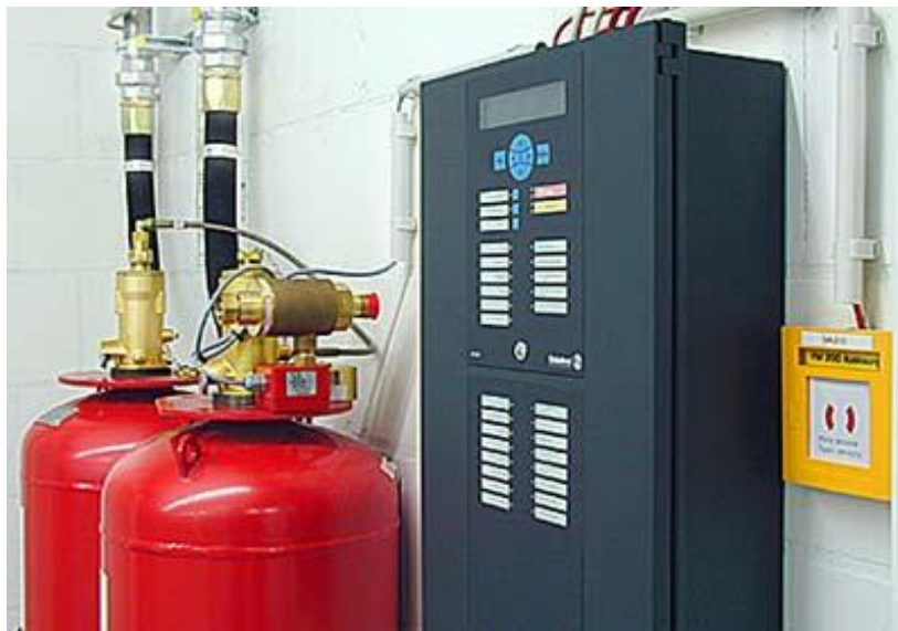
Abbildung 8: FM 200 Löschmittelbevorratung mit Steuerschrank
